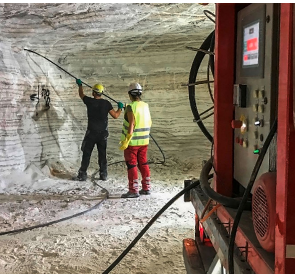
Abb. 9: Ladearbeiten mit Emulsionssprengstoff, Mischladetechnologie
