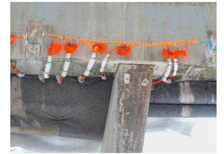
Abb. 7: Verbindung der elektronischen Zünder, Foto: Lankes
