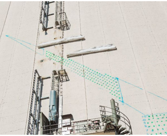
Abb. 1: Gekennzeichneter und gebohrter rechter schräger Fallschlitz oben, Foto: Lankes
