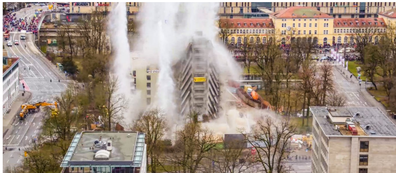
Abb. 4: Sprengung des Luther-Wohnhochhauses, Foto: Stadt Regensburg
